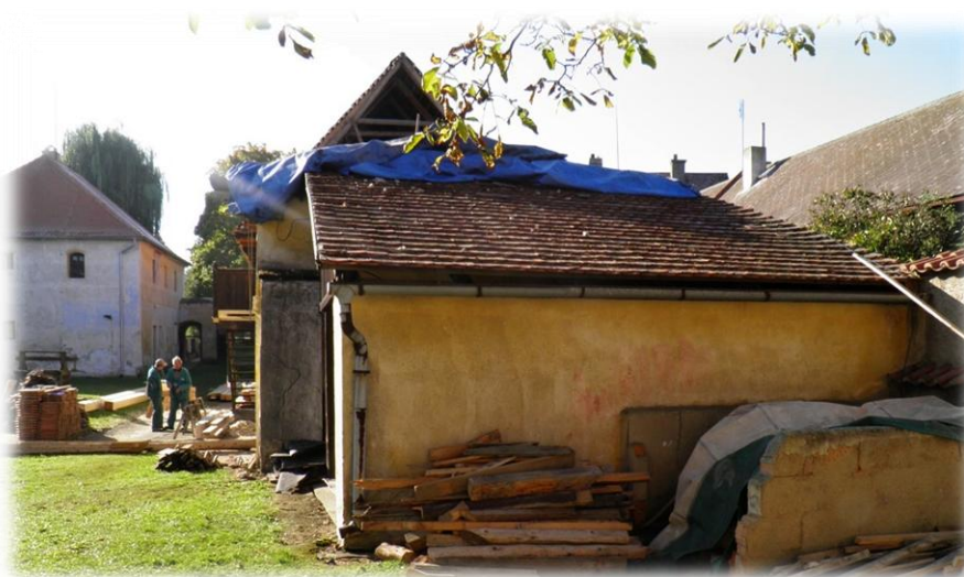
Snímek z opravy střechy v areálu čp.2 v Třebízi (foto ing. Tomáš Kluiber).
