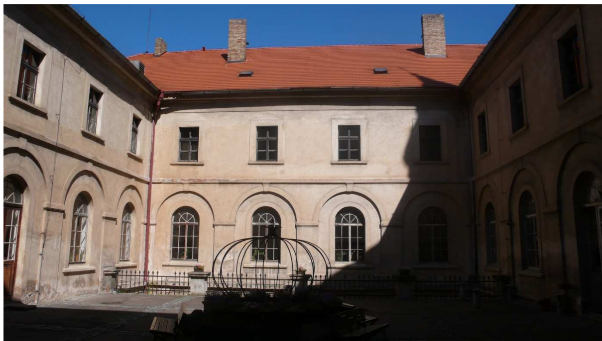
Pohled na opravenou část střechy ve dvoře býv. piaristické koleje.
